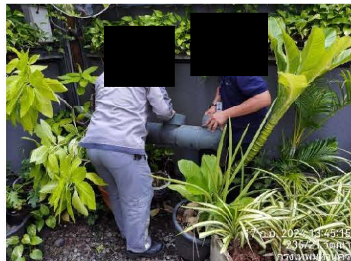
เจ้าหน้าที่เปลี่ยนถ่านตัวกลางระบบมีเทน และ Aerosol
